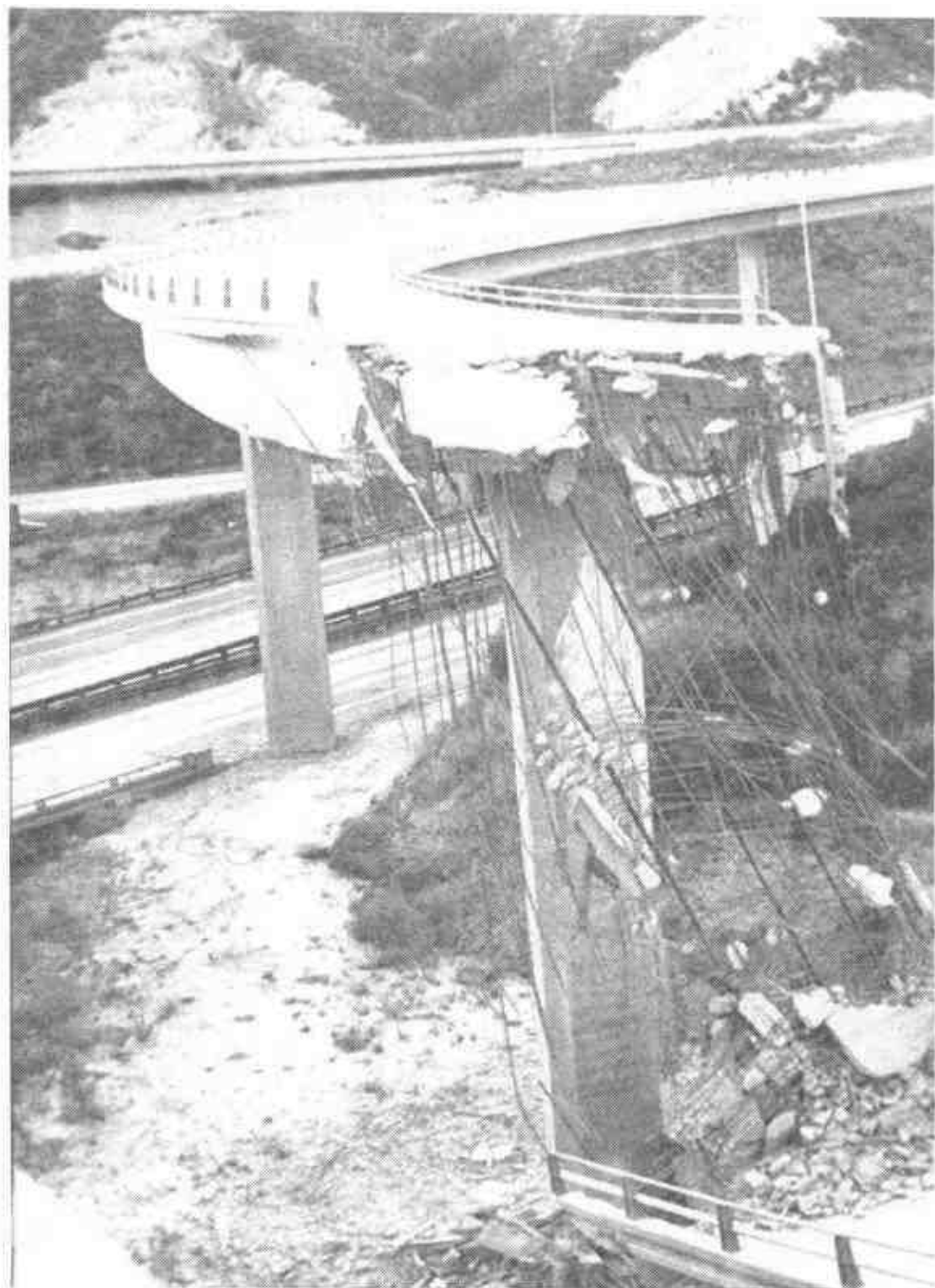
图 1.9 州际 5 号公路/14 号国道互通立交北接线段部分跨塌落
