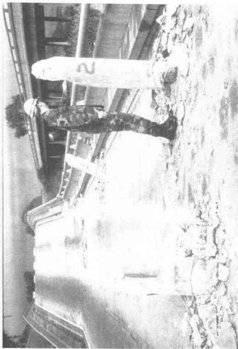
图 1.7 Struve Slough 桥桥墩穿透桥面
