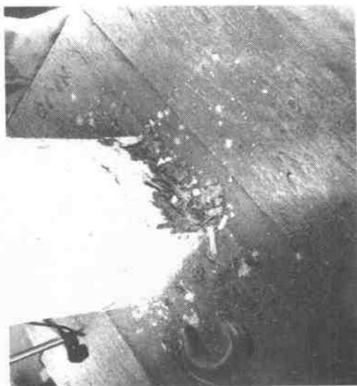
c) 墩底保护层混凝土大量压溃
