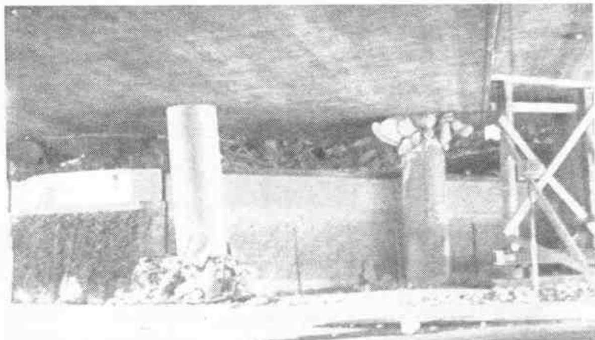
图 1.11 La Cienega-Venice 跨线桥桥墩遭受严重破坏
