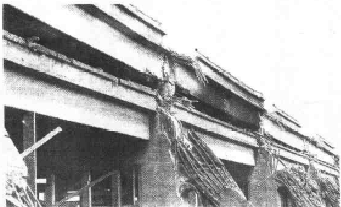
a) 塞普里斯双层高架配筋锚固破坏
