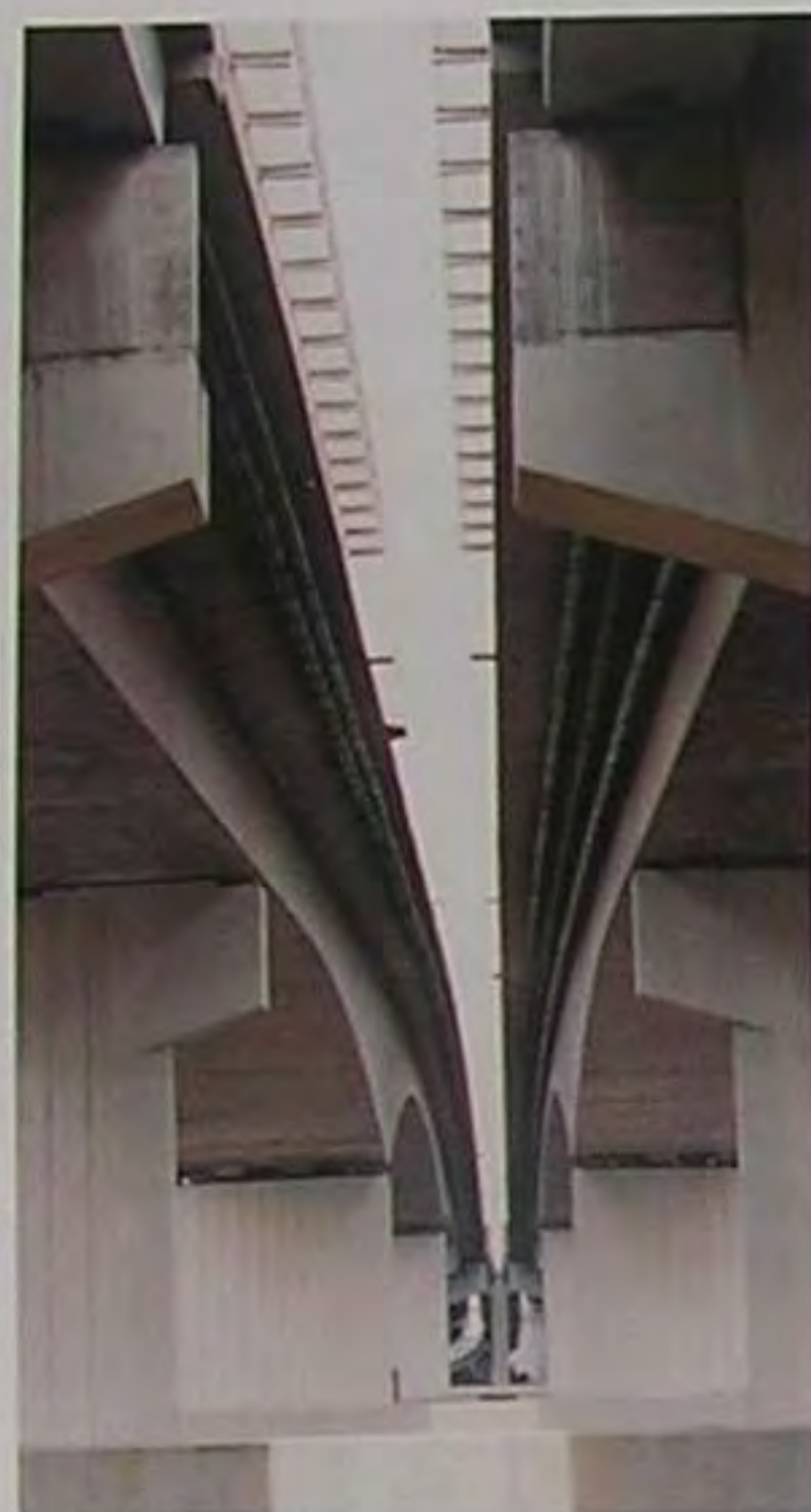
阿考斯塔 (Acosta) 桥的主跨是为每方向三车道和一条轻轨设计的。在引桥部分，轻轨则由分离的结构支持。
