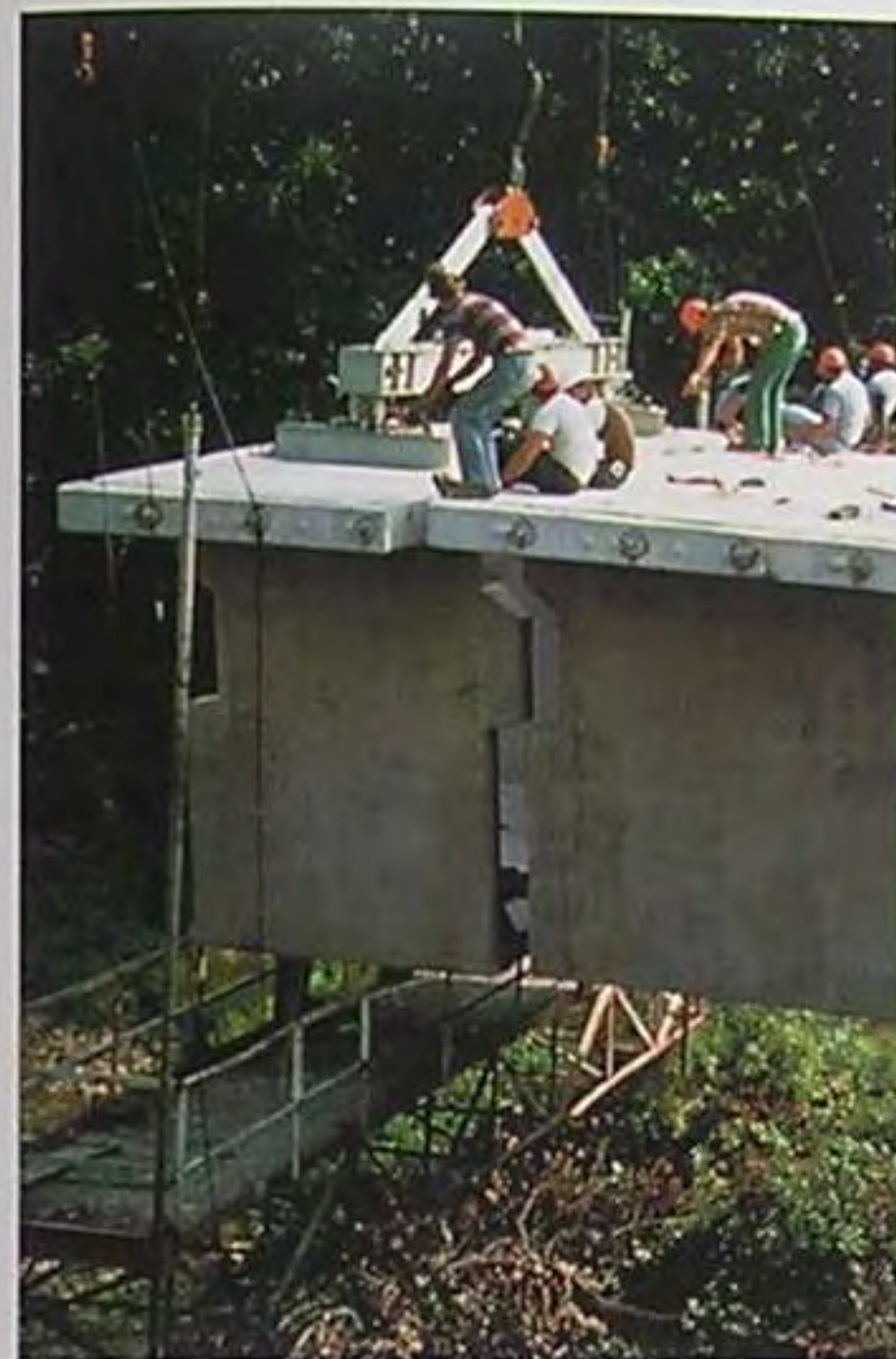
这座桥有两个上部结构, 各宽12.5米。典型跨度76.2米。
