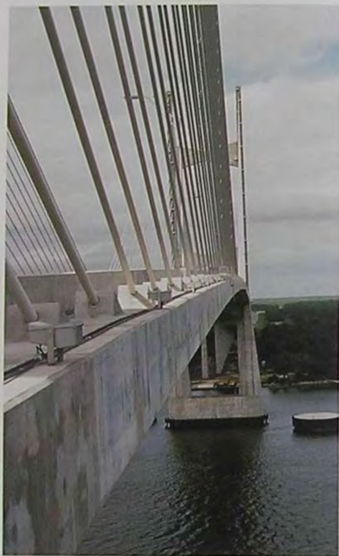
桥塔的基础用巨大的护墩桩保护，以防止船舶撞击。
