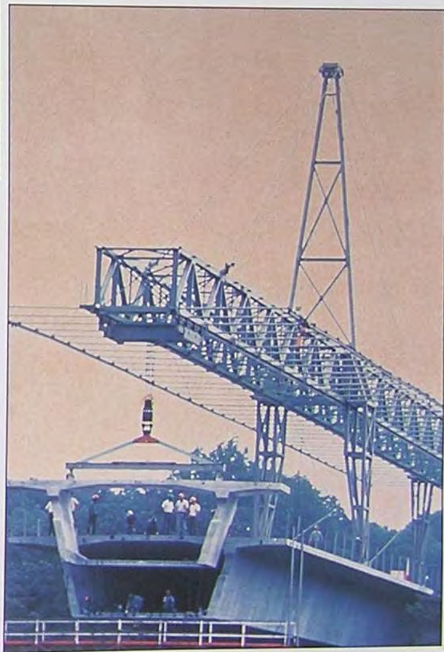
这座桥有两个上部结构, 各宽12.5米。典型跨度76.2米。
