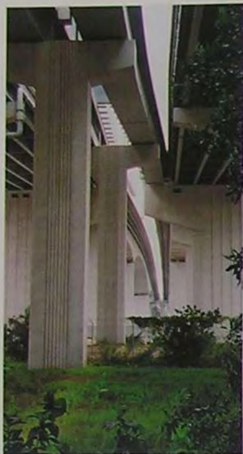
阿考斯塔 (Acosta) 桥的主跨是为每方向三车道和一条轻轨设计的。在引桥部分，轻轨则由分离的结构支持。
