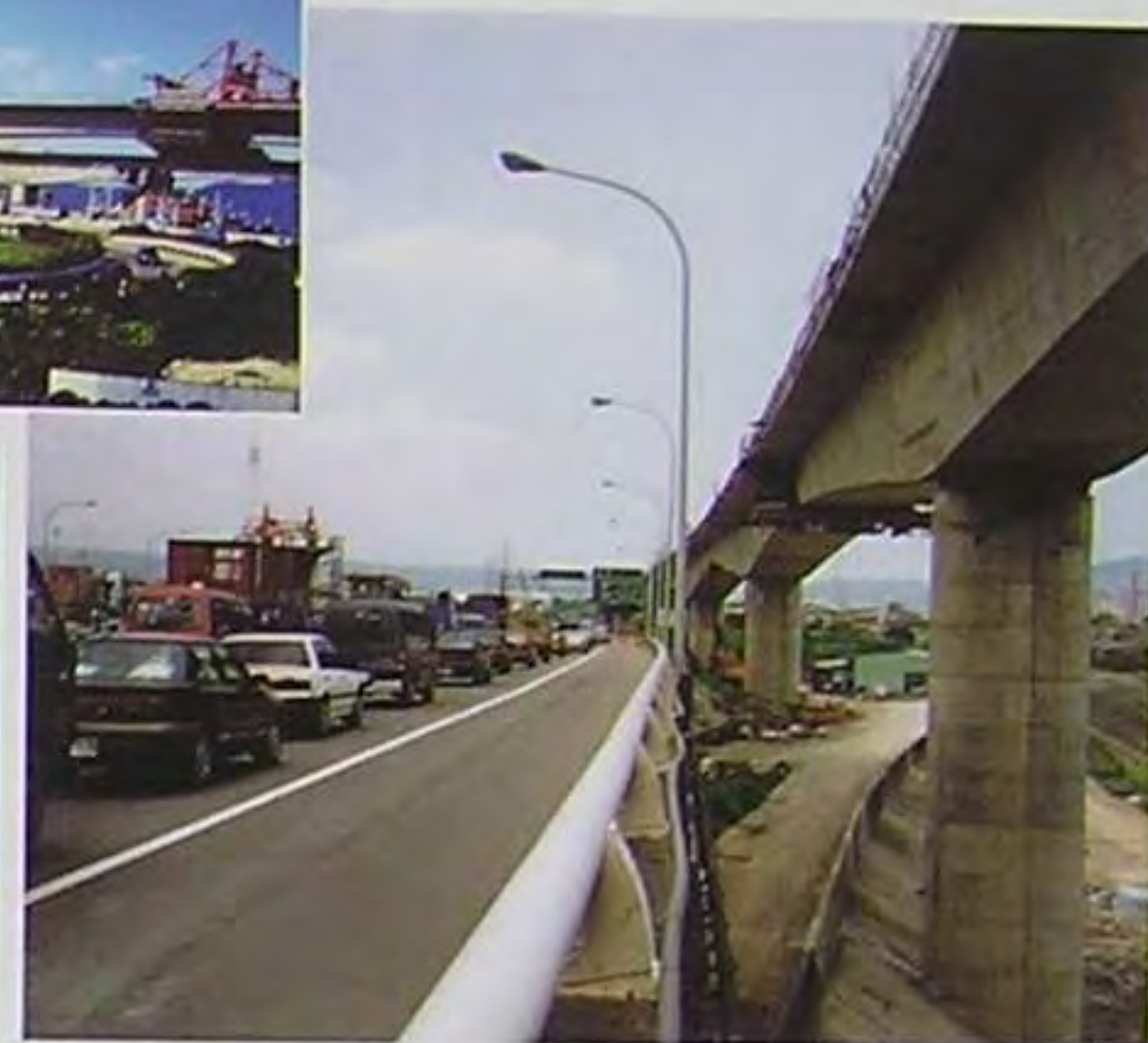
现浇施工中的平衡悬臂梁及其上的挂篮。
