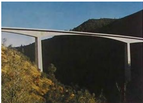
图 8-29 单薄壁墩刚构桥
