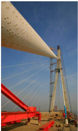
图 5-131 苏通大桥斜拉索
