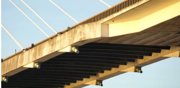
图 5-146 斜拉与连续梁悬臂部分连接处构造图
