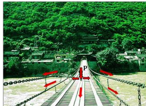
图 6-2 有桥面系吊桥受力图示
