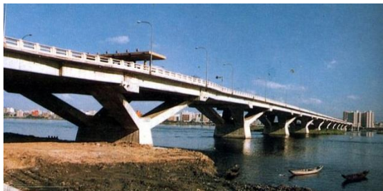
图 8-31 V 形墩刚构桥
