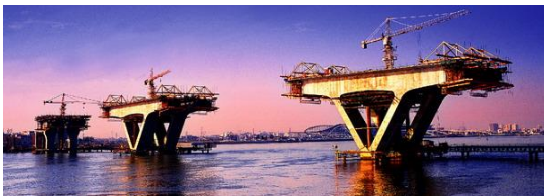
图 3-53 箱梁施工
