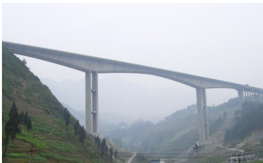
图 8-30 双薄壁墩刚构桥
