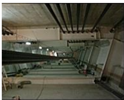
图 5-153 波形钢腹板主梁与体外预应力索(mm)
