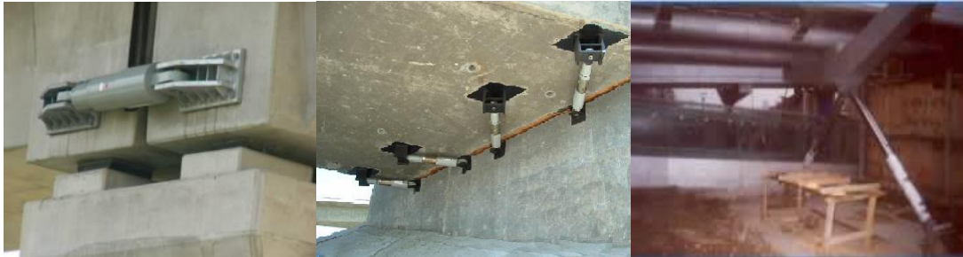
图 2-97 桥梁中的阻尼器
