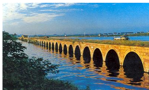
图 4-5 薄墩薄拱石拱桥
