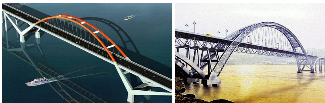
图 4-101 中承式系梁拱桥边跨有无立杆设置对比
