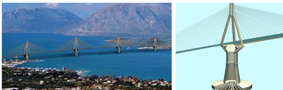
图 5-21 希腊 Rion-Antirion 桥及索塔基础示意图
