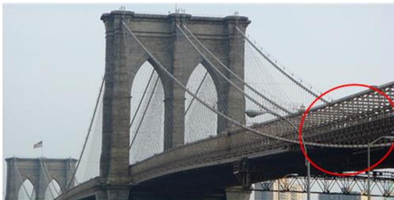
图 6-78 布鲁克林桥加劲梁下的支承短柱
