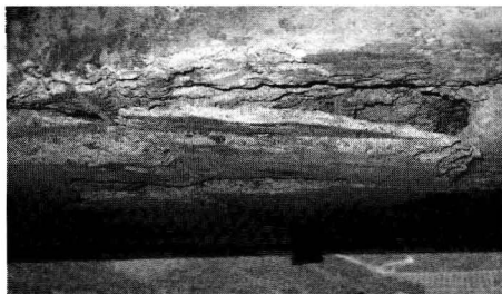
图 6-23 底板混凝土剥落
