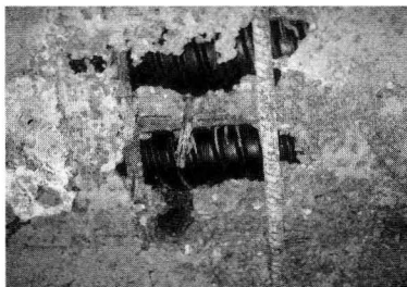
图 6-24 底板崩裂致使波纹管外露
