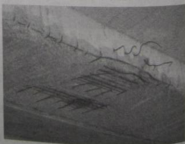
图 8-21 混凝土撞损钢筋断裂
