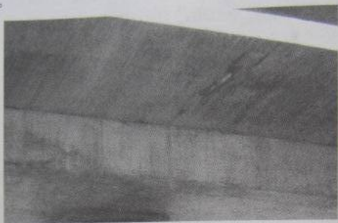
图 8-22 水蚀混凝土
