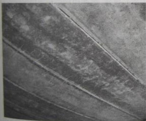
图 8-16 梁底大量横向裂缝
