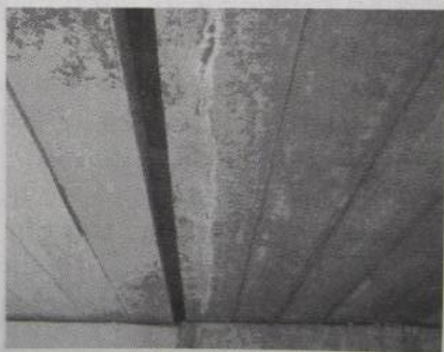
图 8-17 梁底纵向裂缝
