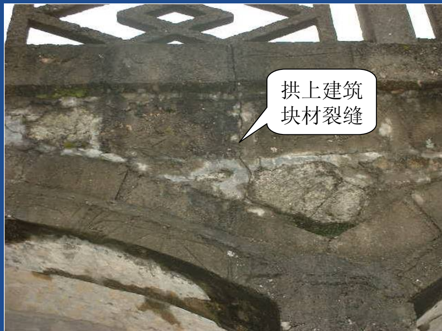
拱上建筑块材间裂缝示意图
