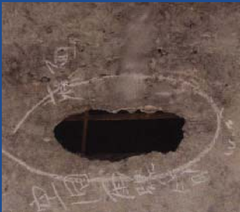
空心板钢绞线的均匀腐蚀
