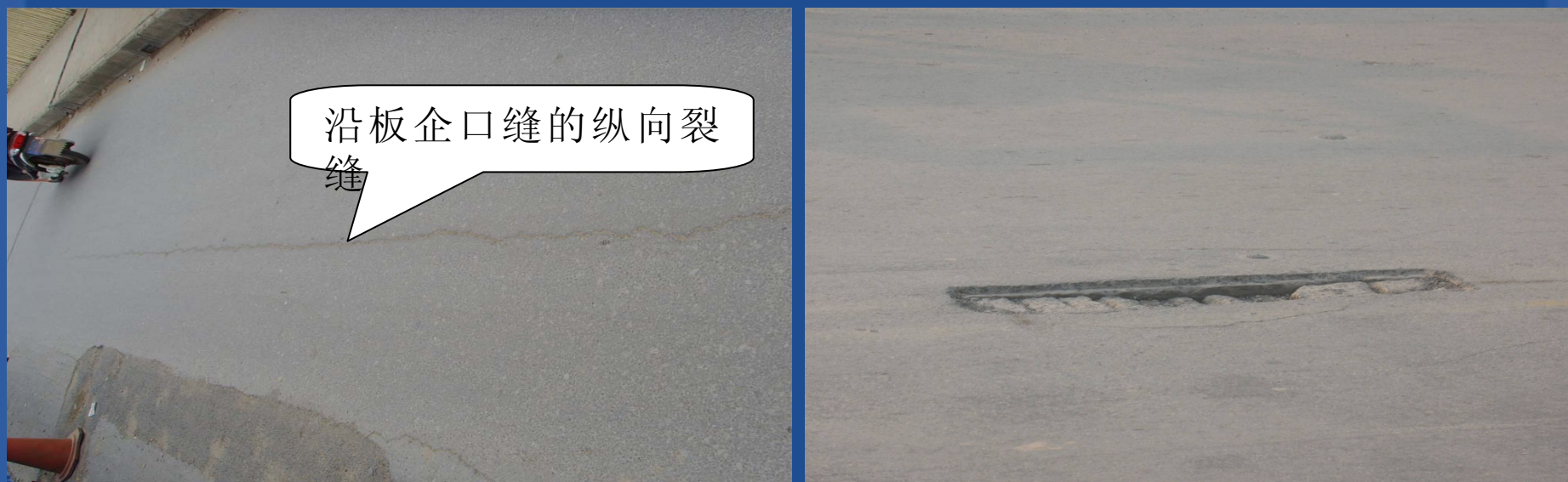
装配式混凝土梁（板）桥面铺装纵向裂缝
