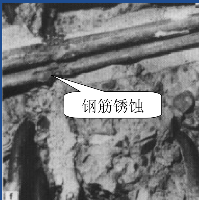
Ynys-y-Gwas桥工字梁预应力钢筋锈蚀
