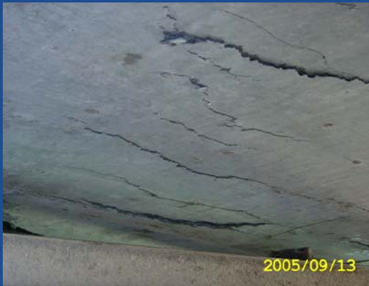
合拢段箱梁的底板纵向裂缝
