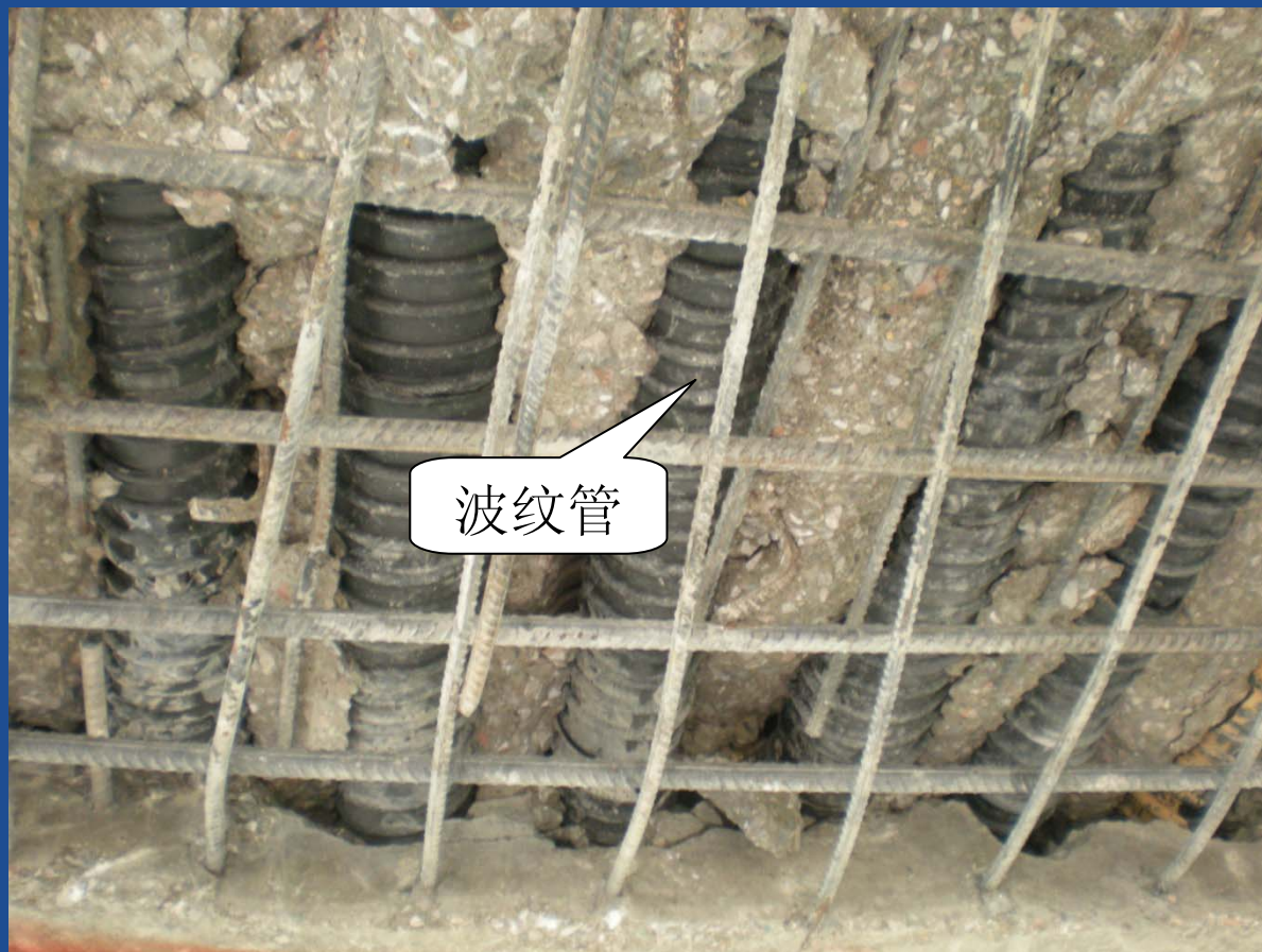
合拢段箱梁的底板纵向裂缝
