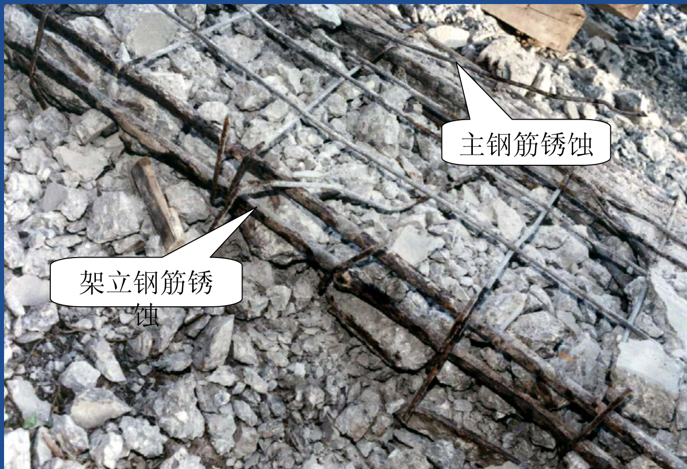
焊接钢筋骨架锈蚀
