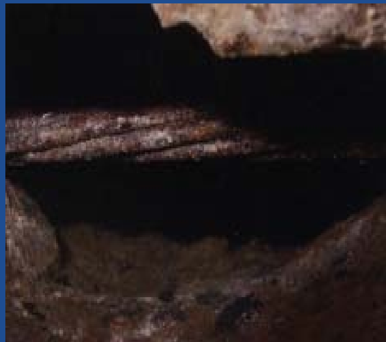
空心板钢绞线的均匀腐蚀
