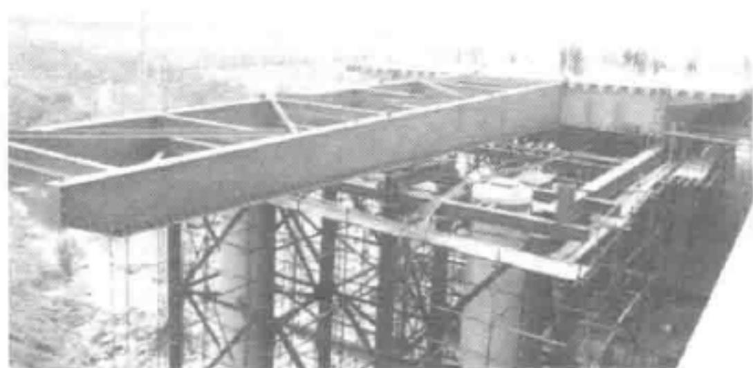
图 9-8 跨沪宁高速公路钢箱梁顶推架设
