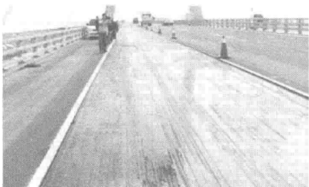
图 10-6 润扬大桥北汊桥修复中的桥面铺装
