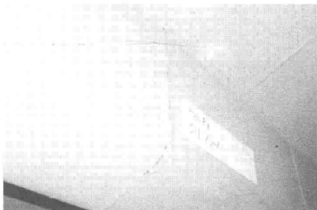
图 6-18 纵肋嵌补段处由于荷载引起的疲劳裂纹实桥照片
