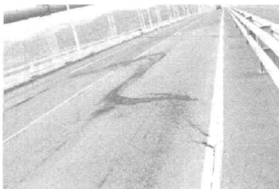
b)严重推移导致的裂痕
