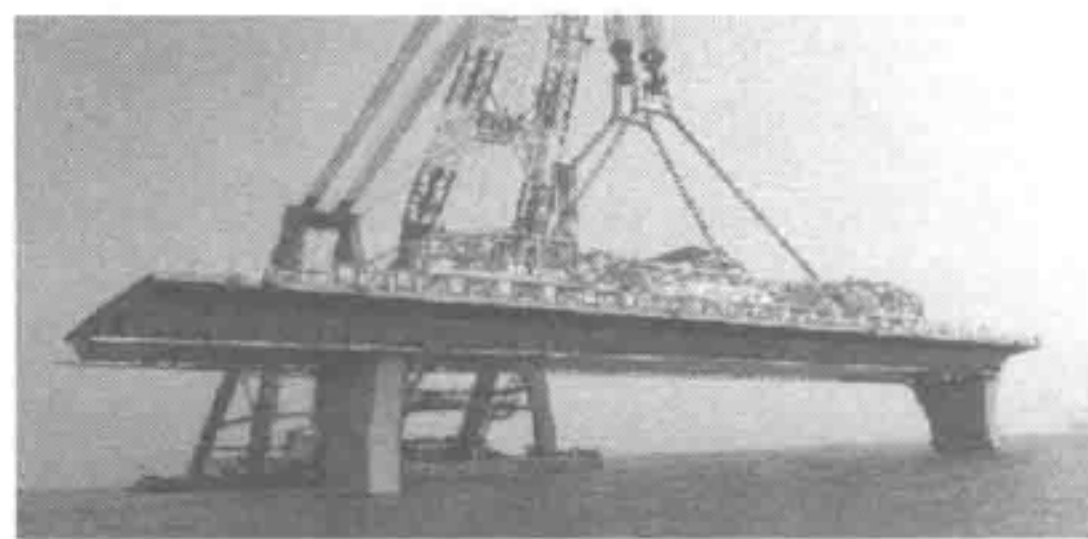
图 9-9 港珠澳大桥大跨度连续钢箱梁首段吊装
